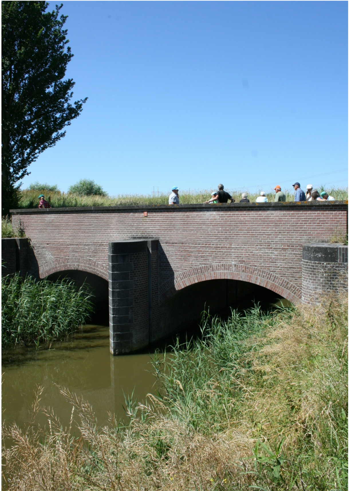
Bij de Damsluis kon het water geblokkeerd worden door het plaatsen van dikke balken. In het kader van herstel van cultuurhistorisch erfgoed zijn de verloren balken weer teruggeplaatst onder een afdakje in het aangrenzende perceel, alsof ze klaar liggen om zo weer gebruikt te worden.
