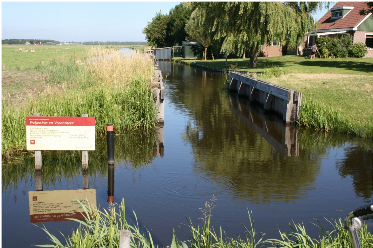
De eerste stopplek is al enkele honderden meters na het startpunt bij de Overtoomsloot aan de slingerende weg Busch en Dam. In deze watergang, die de liniedijk onderbreekt, is een houten bouwwerk aangelegd, dat als doel had de watergang te kunnen sluiten zodat het gebied erachter kon worden geïnundeerd (onder water gezet) om de vijand tegen te houden in tijden van oorlog. Het bouwwerk ligt er strak bij doordat het is gerestaureerd.
