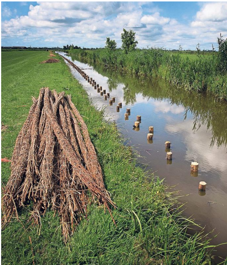
In Middellie is een dubbele rij palen geslagen en liggen de bossen rijshout klaar.
